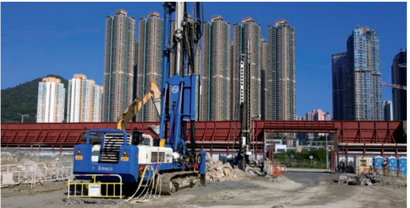
Nelle foto, perforatrici Soilmec al lavoro sullo sfondo dello skyline di Tseung Kwan O. In the pictures, Soilmec drilling rigs at work with in the background the Tseung Kwan O skyline.
