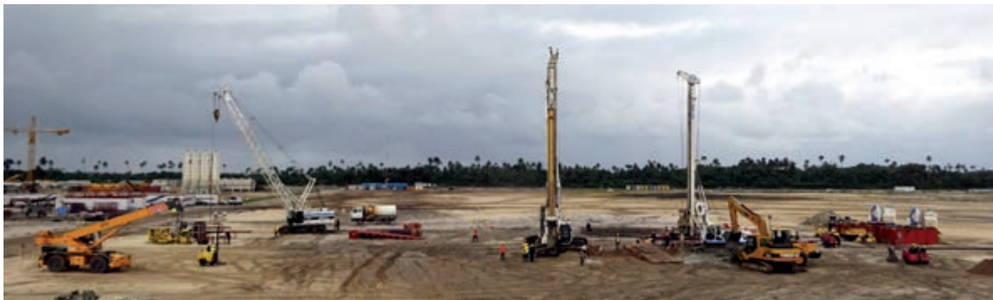
L'esteso cantiere per la costruzione del nuovo stabilimento chimico./ The extensive construction site for the chemical plant.
