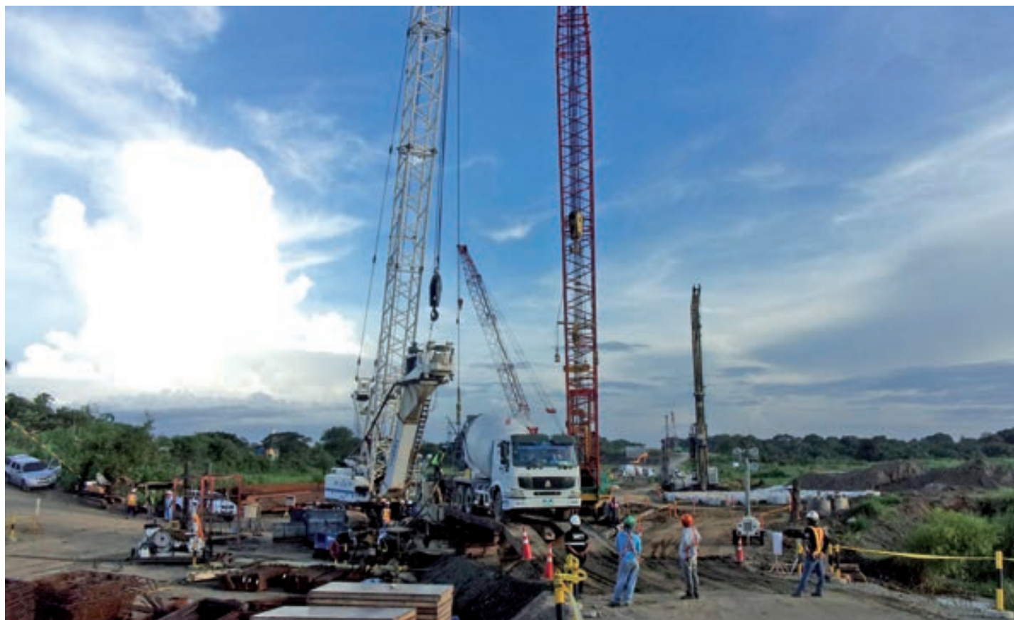
Nelle foto, Trevi al lavoro per il progetto Plaridel Bypass Road./In the pictures, Trevi at work for the Plaridel Bypass Road project.
