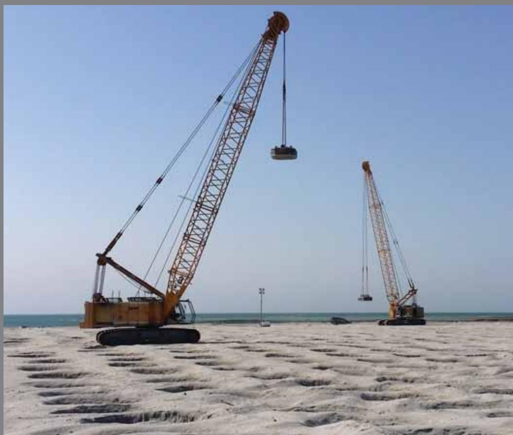
Durante i lavori è stata implementata una rigorosa procedura di garanzia qualità basata sulla registrazione automatica dei parametri di produzione e della risposta del terreno in fase di consolidamento e sulla valutazione sistematica delle caratteristiche del terreno ottenute tramite prove penetrometriche statiche (CPT).
