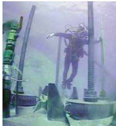
Riempimento cassone Anchor block filling
