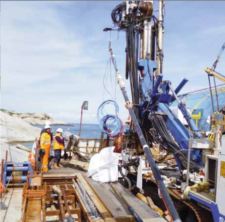
Installazione barra / Tendon installation
