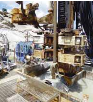
Perforazioni con martello fondo foro DTH drilling
