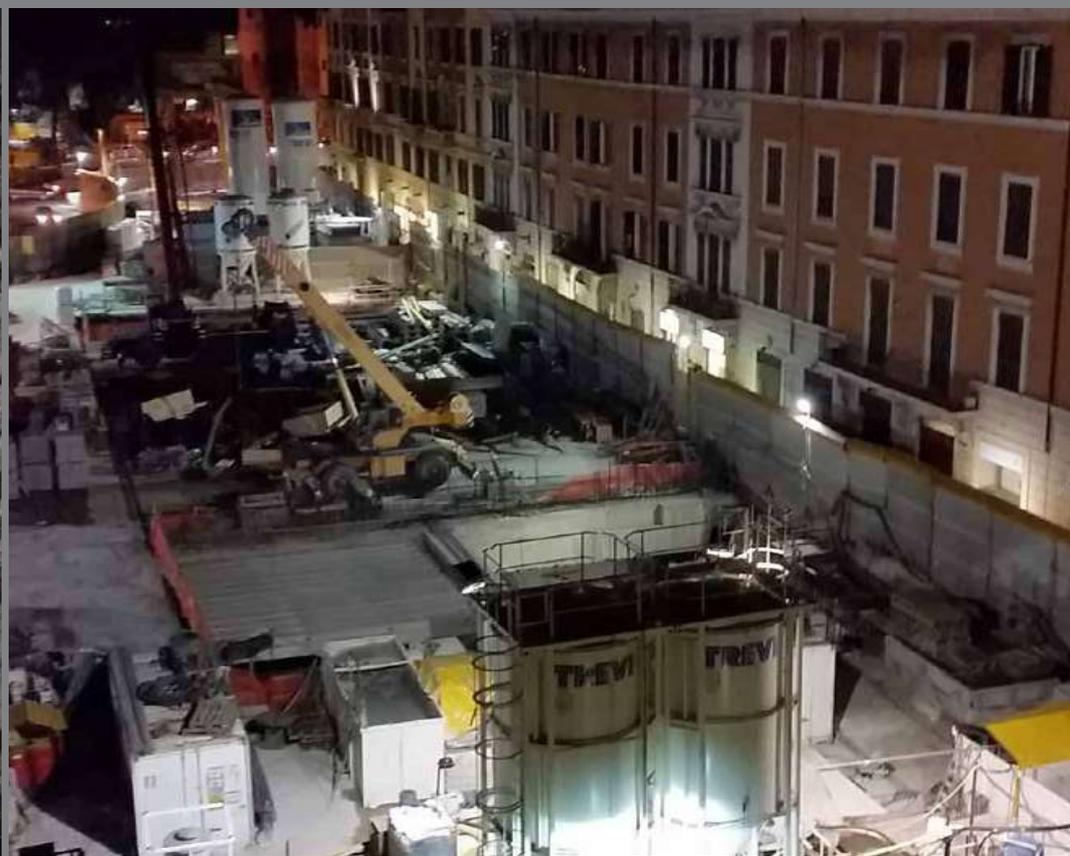
in opera di strutture provvisorie per il sostegno dei binari durante la fase di consolidamento e di scavo del sotto-attraversamento (ponti metallici fondati su micropali) ed è stato attivato un sistema per il monitoraggio strutturale.
