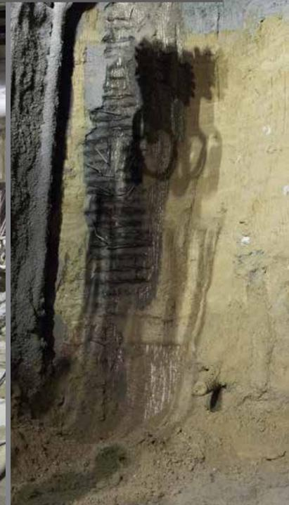
**per le condizioni stratigrafiche e idrauliche del sito, anche a causa delle strutture pre-esistenti, in particolare i pali di fondazione della linea "A", che hanno imposto interessi tra le canne congelatrici di oltre 3 metri e mezzo.**
