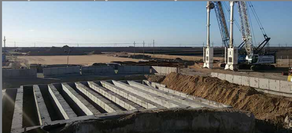
Dettaglio setti trasversali all'interno del pozzo di lancio / Cutting detail of the transverse diaphragm walls inside the launching shaft
