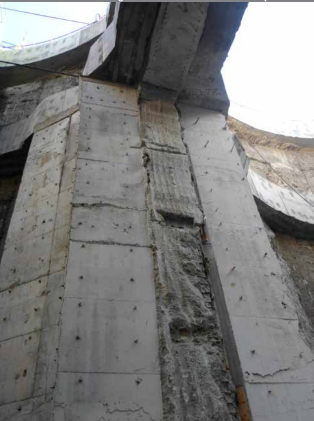
Dettaglio setti trasversali all'interno del pozzo di lancio / Cutting detail of the transverse diaphragm walls inside the launching shaft
