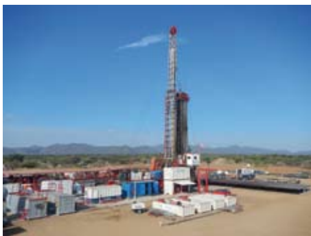
L'impianto Drillmec MR8000 in Kenya. Drillmec MR8000 plant in Kenya.
