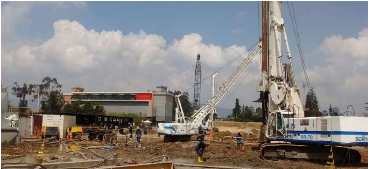
Il cantiere per la costruzione del nuovo edificio dell'Universidad de la Sabana./The construction site of the new building of Universidad de la Sabana.
