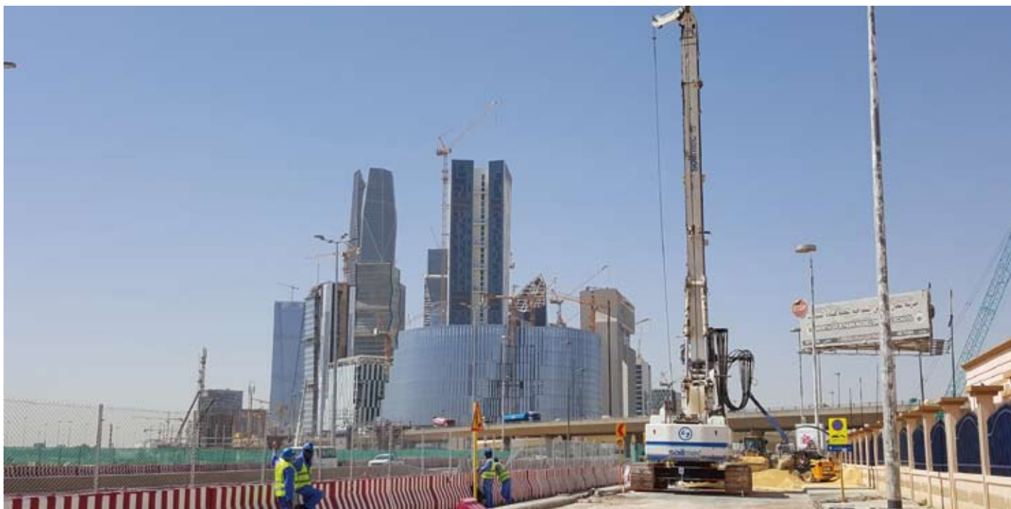
Lavorazioni nell'ambito dei cantieri per la Metro di Riad con macchine Soilmec.
