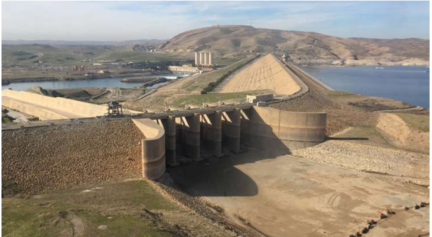
Nelle immagini, viste della diga di Mosul, Iraq./In the photo, view of Mosul Dam, Iraq
