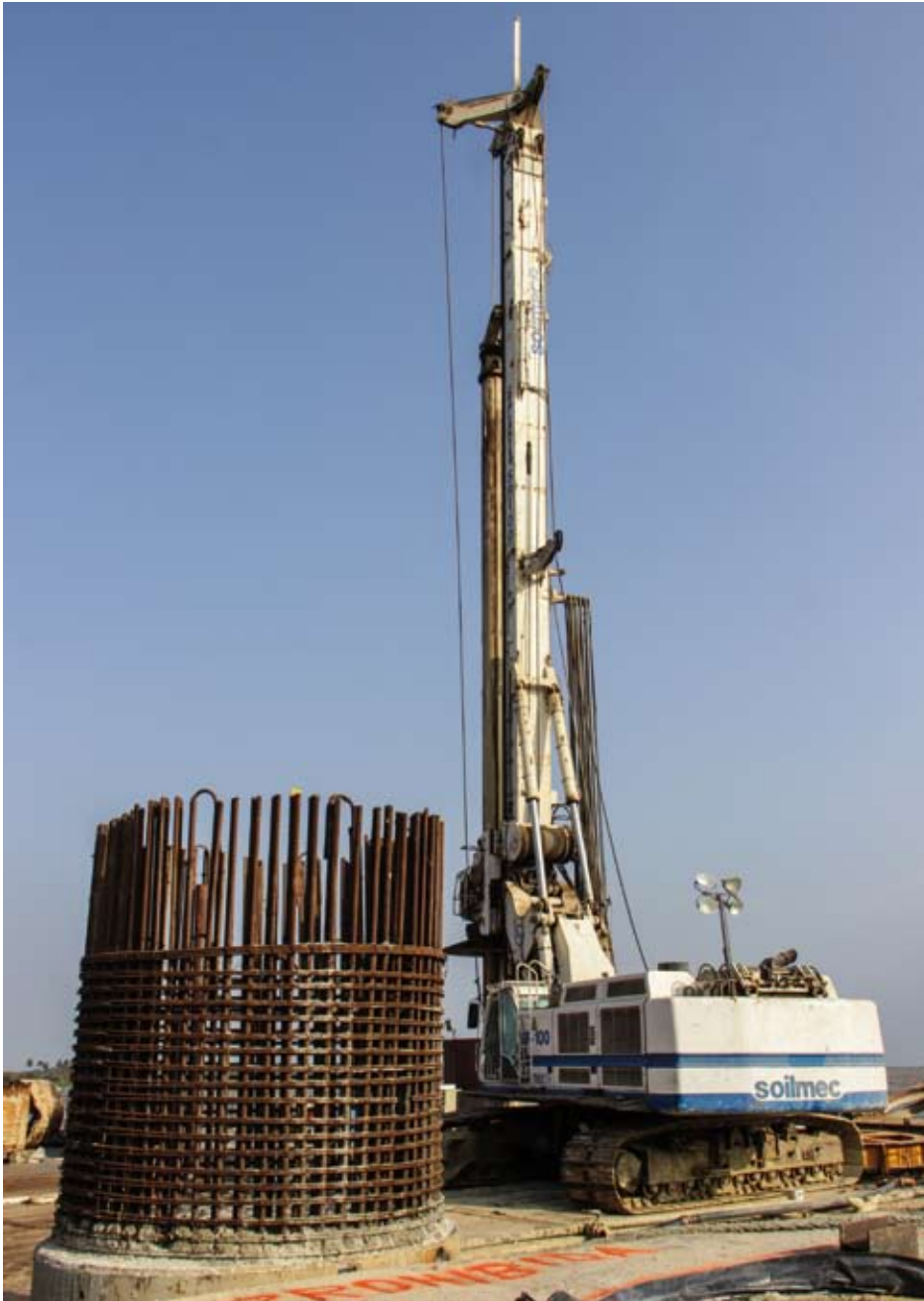
Le foto mostrano le armature per i pali di grande diametro e le lavorazioni a terra e in acqua. The photos show the steel cage for large diameter piles and the works in the ground and in the water.
