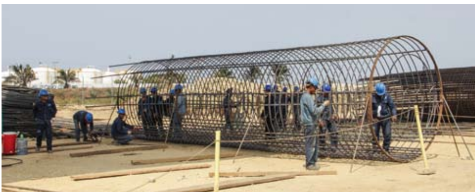
Le foto mostrano le armature per i pali di grande diametro e le lavorazioni a terra e in acqua. The photos show the steel cage for large diameter piles and the works in the ground and in the water.
