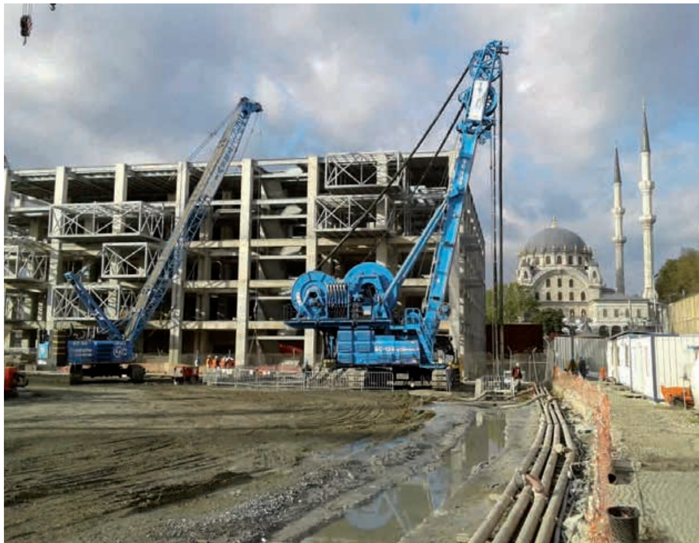
Per la realizzazione del Salipazari Port project sono al lavoro macchine Soilmec tra cui la nuova idrofresa Soilmec SC-135. The realization of the Salipazari Port project requires Soilmec machines including the new hydromill Soilmec SC-135.
