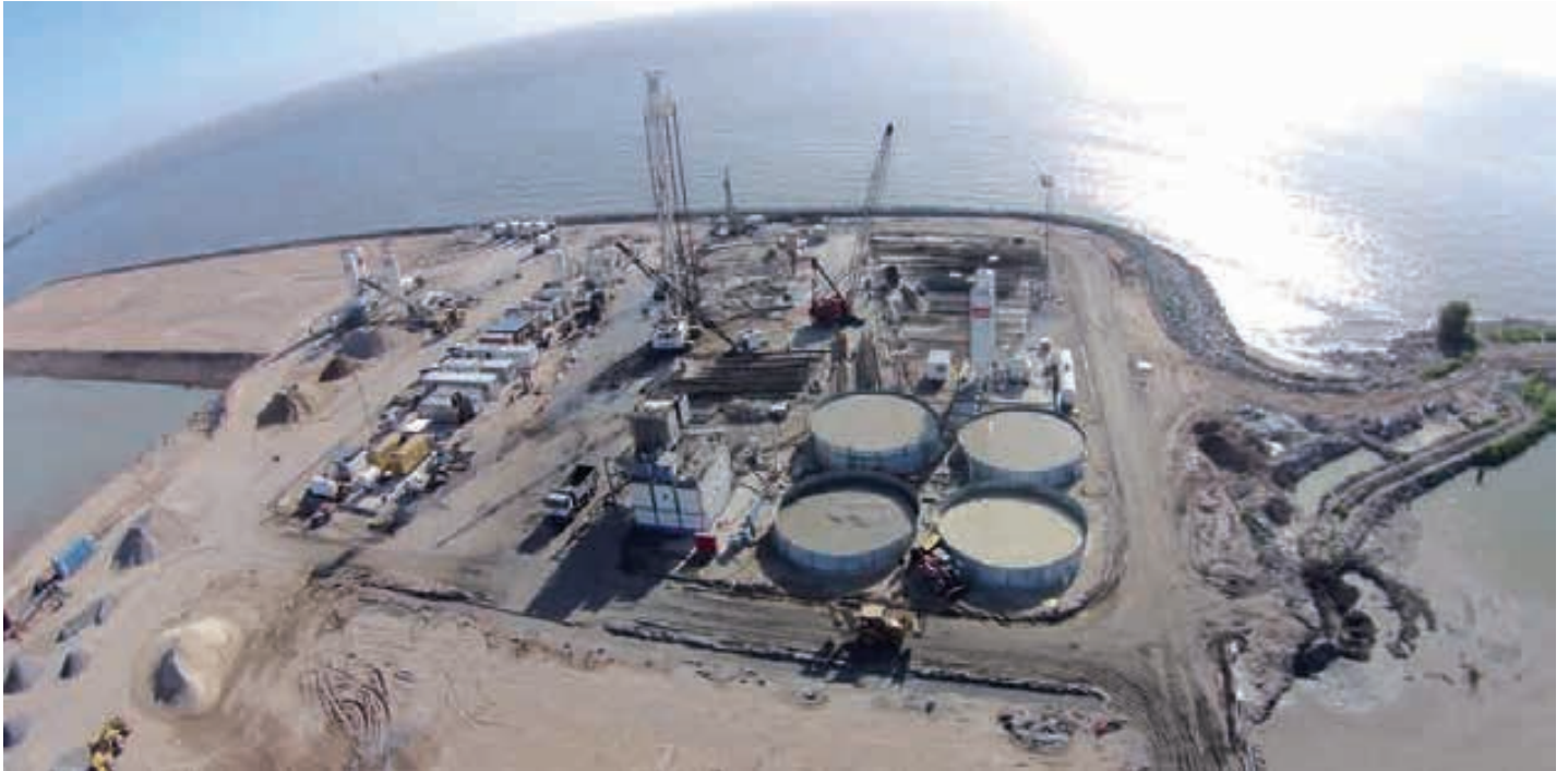
Nelle foto, sopra, vista del cantiere del Emisario Planta Raichuelo lote 3 a Buenos Aires, sotto, il team di cantiere festeggia il record. In the pictures, above, view of the construction site of Emisario Raichuelo Planta lote 3 in Buenos Aires, below, the construction team celebrates record.
