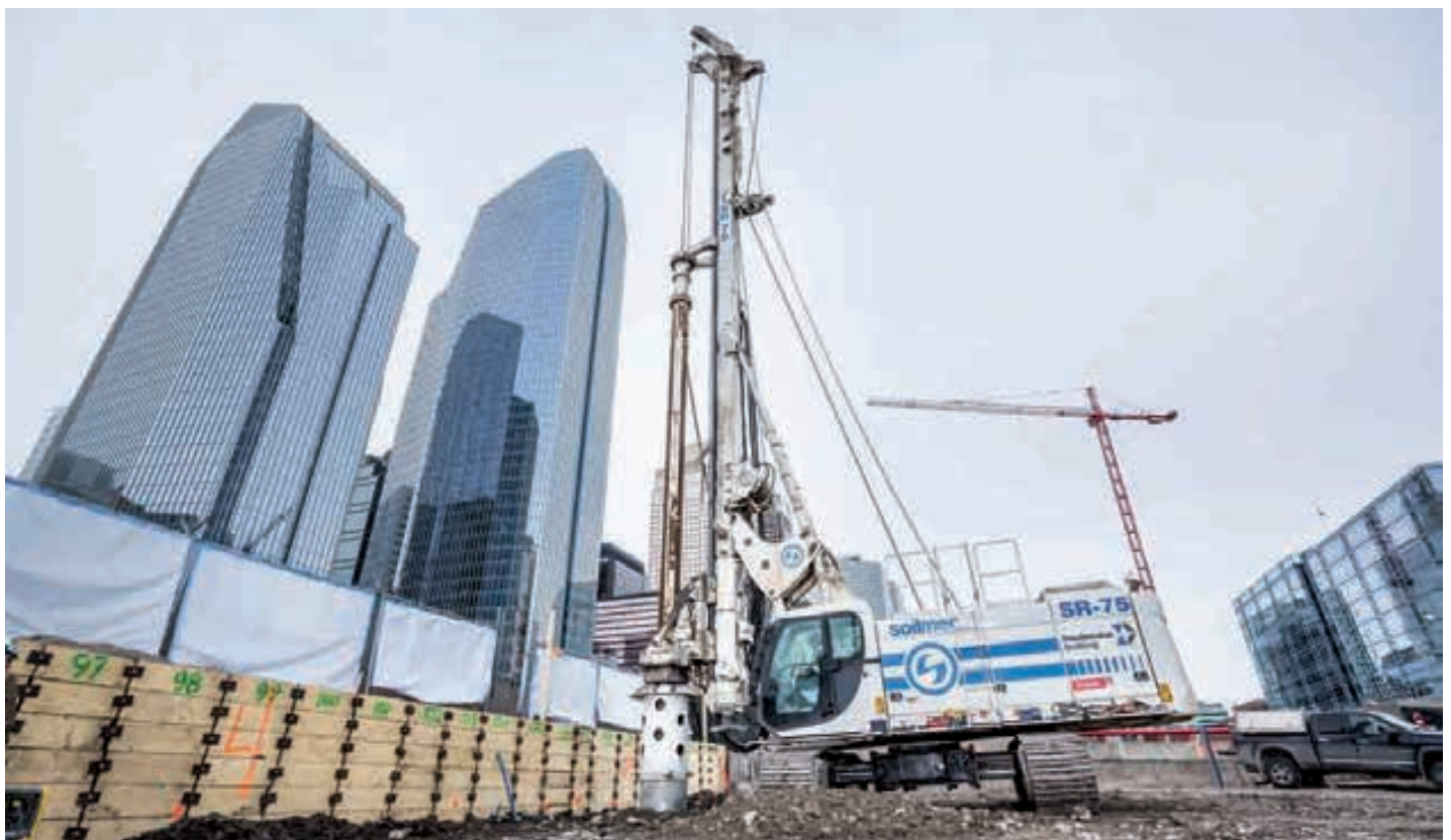
Soilmec SR-75 per le fondazioni del nuovo complesso "Alberta Boot". / Soilmec SR-75 for the foundations work of new complex "Alberta Boot".
