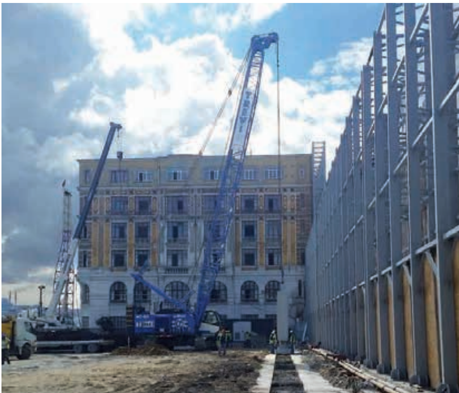
Realizzazione del diaframma con Soilmec SC-90 attrezzata con benna meccanica. Construction of the diaphragm with Soilmec SC-90 with cable grab.
