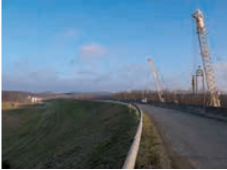
Vista particolare della Diga Bolivar. Particular view of Bolivar Dam.
