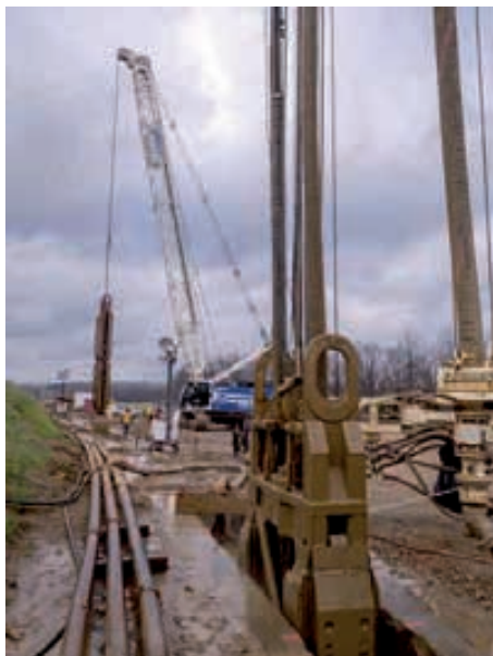
Dettaglio della lavorazione./Detail of works.
