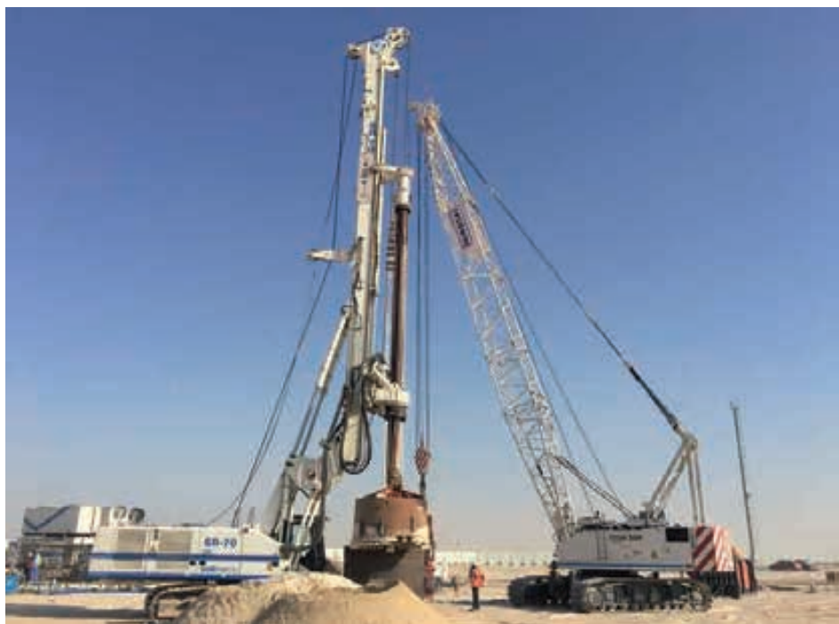
Macchine Soilmec al lavoro per l'espansione della metropolitana di Dubai. Soilmec machines at work for the Dubai Metro expansion project.
