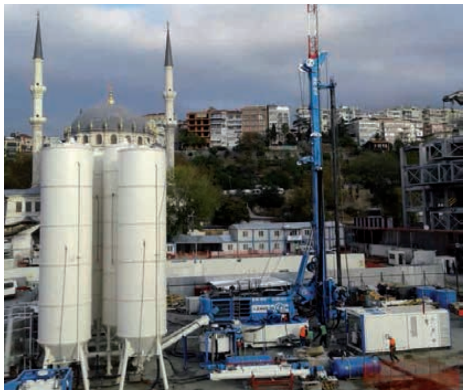
L'impianto di cantiere Trevi e una nuova Soilmec SR-95 in allestimento TurboJet sullo sfondo di Istanbul. The Trevi site plant and a new Soilmec SR-95 in TurboJet configuration on Istanbul background.
