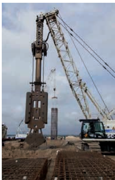
Dettaglio della lavorazione./Detail of works.
