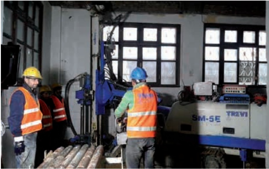
Soilmec SM-5E al lavoro nel cantiere Trevi di Istanbul./Soilmec SM-5E at work in Trevi yard in Istanbul.
