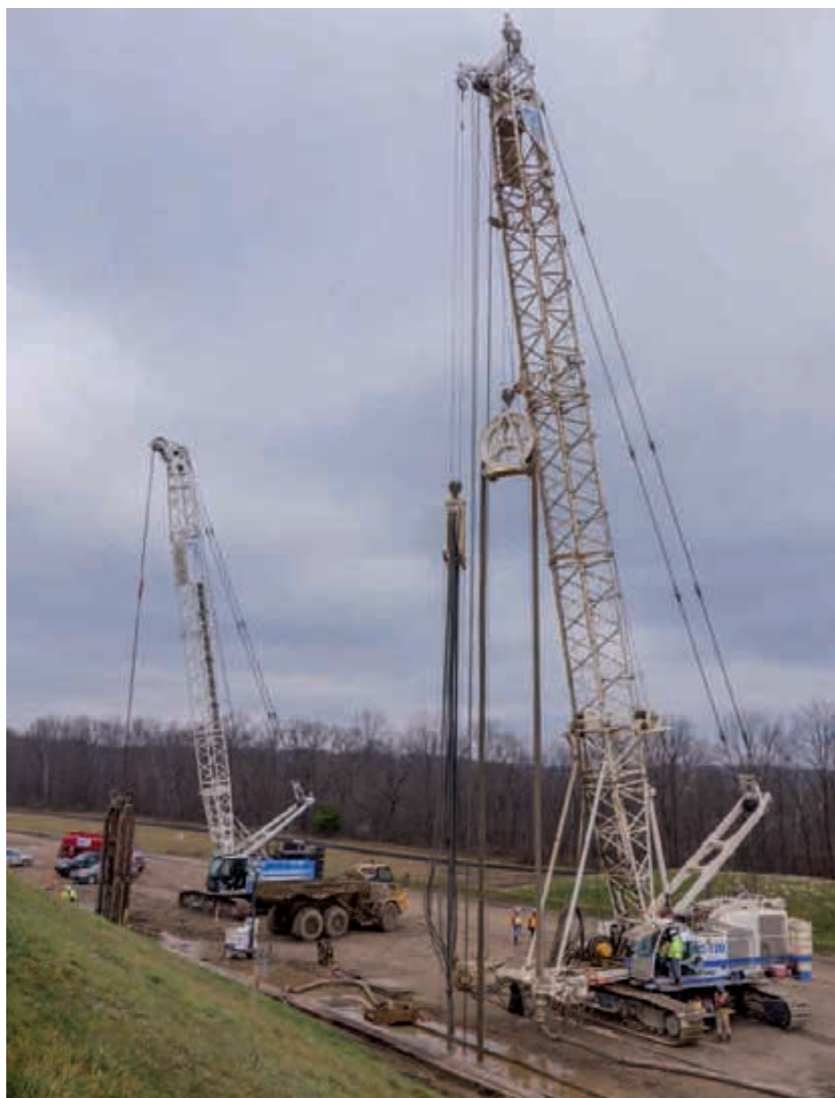
Macchine Soilmec al lavoro per la barriera di contenimento della Diga Bolivar. Soilmec rigs at work for Bolivar Dam seepage barrier wall.
